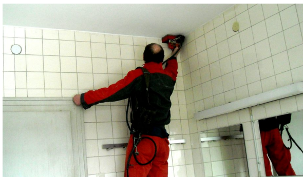
Abb. F Messung an der Deckenunterseite
