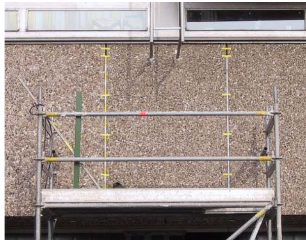
Abb. 1 oben: Foto der untersuchten Fassadenplatte rechts: geöffnete Stelle mit korrodierter Verankerung
