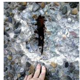
Abb. 1 oben: Foto der untersuchten Fassadenplatte rechts: geöffnete Stelle mit korrodierter Verankerung
