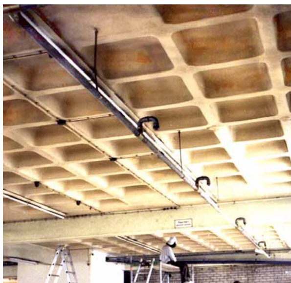
Abb. 1 Blick während der Messung von unten auf die untersuchten Stege der Kassettendecke und die Unterzüge.
