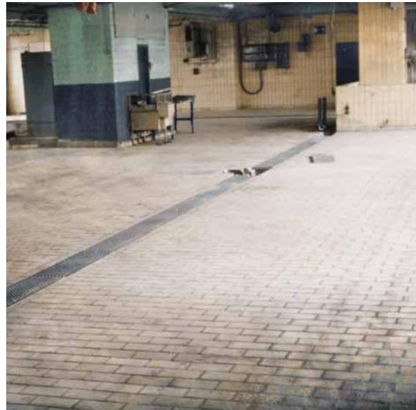
Abb. 2 Blick von oben auf Decke. Die Säureablaufkanäle sind an dem Abdeckgitter im Boden (links im Bild) zu erkennen.
